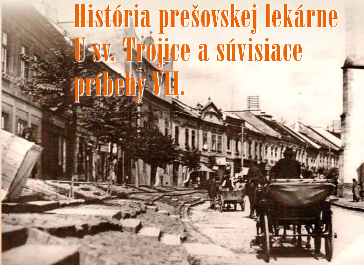
↑ Časť Hlavnej ul. v Prešove v roku 1933: celkom vľavo fasáda lekárne U sv. Trojice so zreteľným cenným dreveným portálom, ktorý bol zničený po jej zoštatnení
