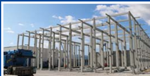
Výstavba prefabrikovaného skeletu stavby (júl 2015)
